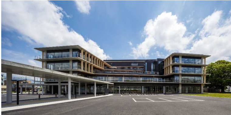
熊本県大津町 (災害復旧事業) 「大津町役場」
