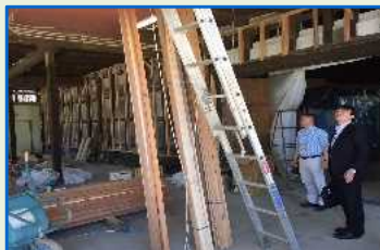
(復旧作業中の酒蔵)
